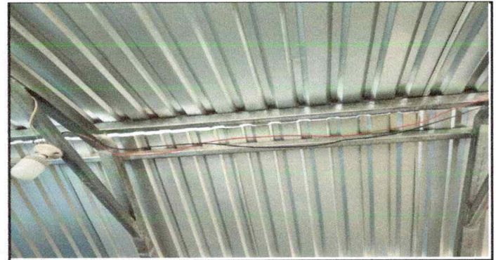
Foto 6: Sustrucción de focos ahorradores, plafoneras, interruptores simples, tomacorrientes dobles, flipones y cableado Modulo 1
