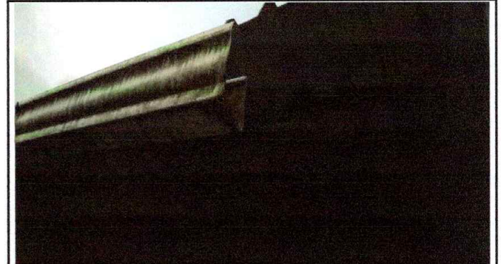
Foto 4: Sustrucción de canales de pvc, por canales pvc Modulo 1
