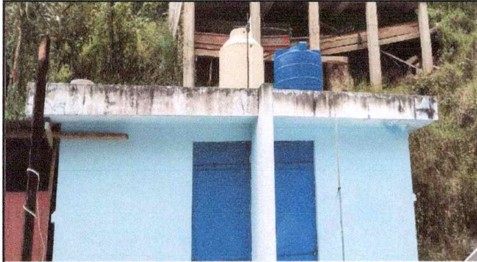
Foto 7: Reparación y mantenimiento de cisternas / deposito de agua Modulo 1
