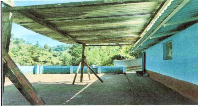
Foto 1: Sustrucción de lámina, por lámina troquelada aluzinc calibre 26 de techo de patio Modulo 1
