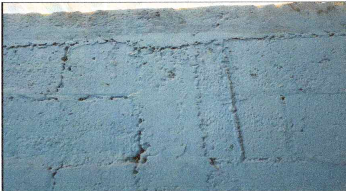
Foto 9: Reparación de repello y cernido de paredes de aula Modulo 1
